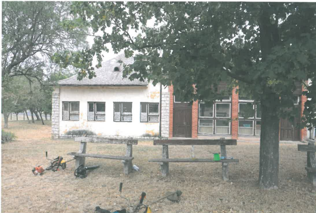
„A” és „B” épületszárny - tornaterem, udvari homlokzat
