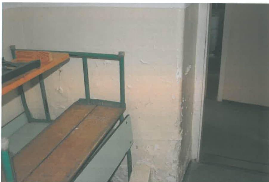
A fal szellőzésének hiánya miatt lepergő vakolat
