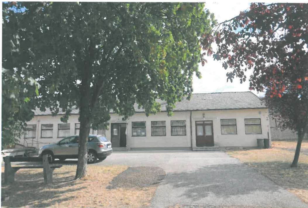
„C” épületszárny, udvari homlokzat
