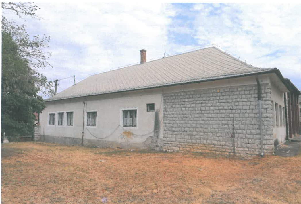
„A” épületszárny, udvari homlokzat, déli oldal
